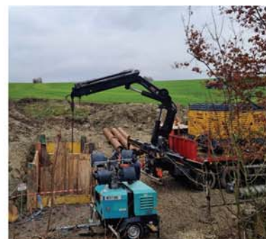
Pose de la conduite de raccordement entre le nouveau puits et la station de pompage de Voellerdingen avec passage sous la voie SNCF.
